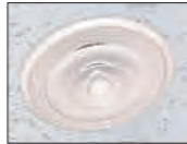
天井吹き出し口(丸) (直径500mm～830mm迄)
